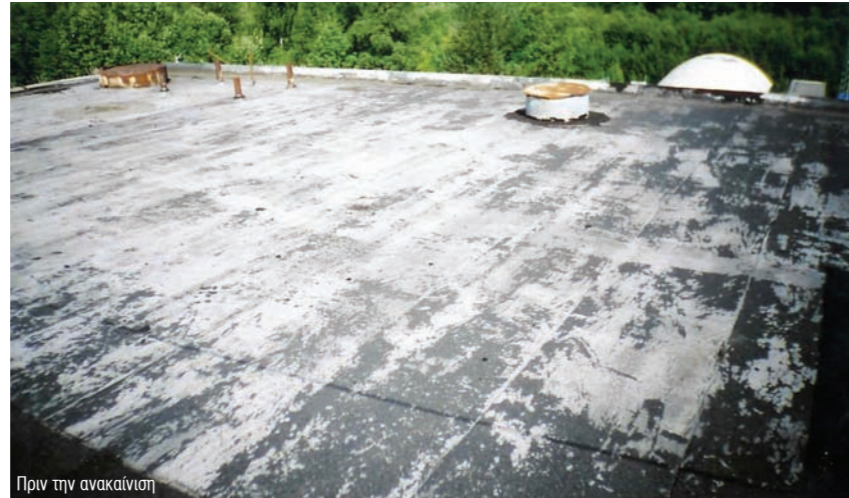
Πριν την ανακαίνιση
