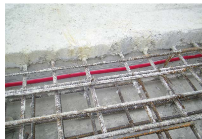
Κατασκευαστικοί αρμοί
