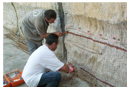
Σύνδεση διαφραγματικών τοίχων
