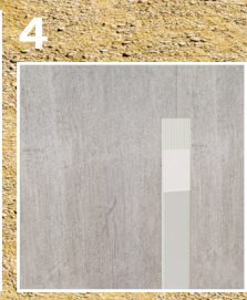
Αρμοί σύνδεσης σκυροδέματος & χάλυβα
