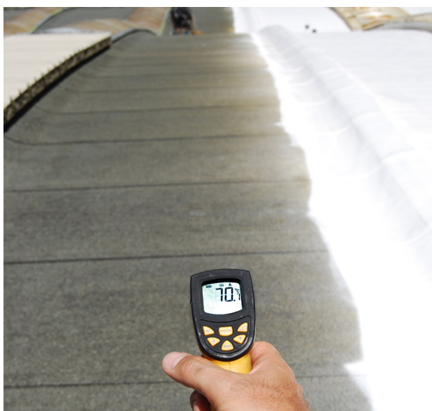
Θερμοκρασία δώματος πριν την εφαρμογή υγρής μεμβράνης
