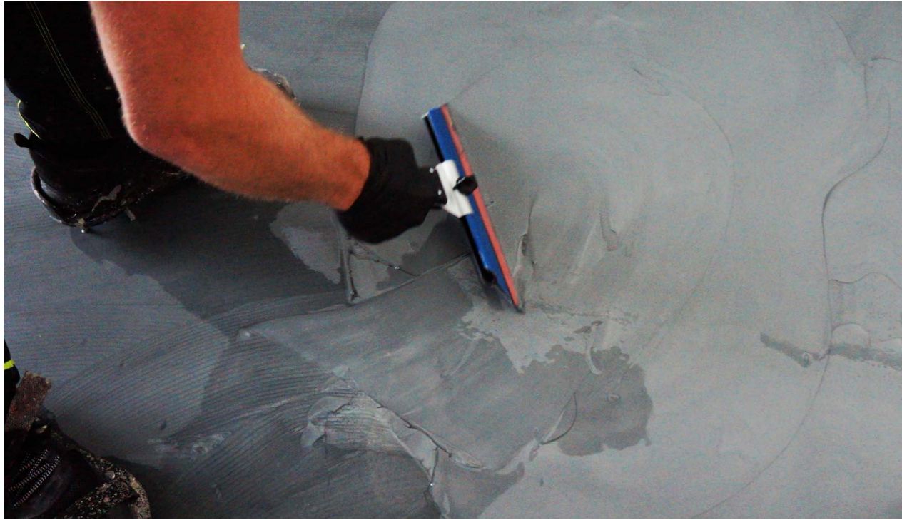
Το Sikafloor®-3000 FX διαστρώνεται στο υπόστρωμα και μετά επεξεργάζεται με κατάλληλα εργαλεία. Αναλόγως του εργαλείου που θα χρησιμοποιηθεί, επιτυγχάνεται διαφορετικό και μοναδικό αποτέλεσμα.
