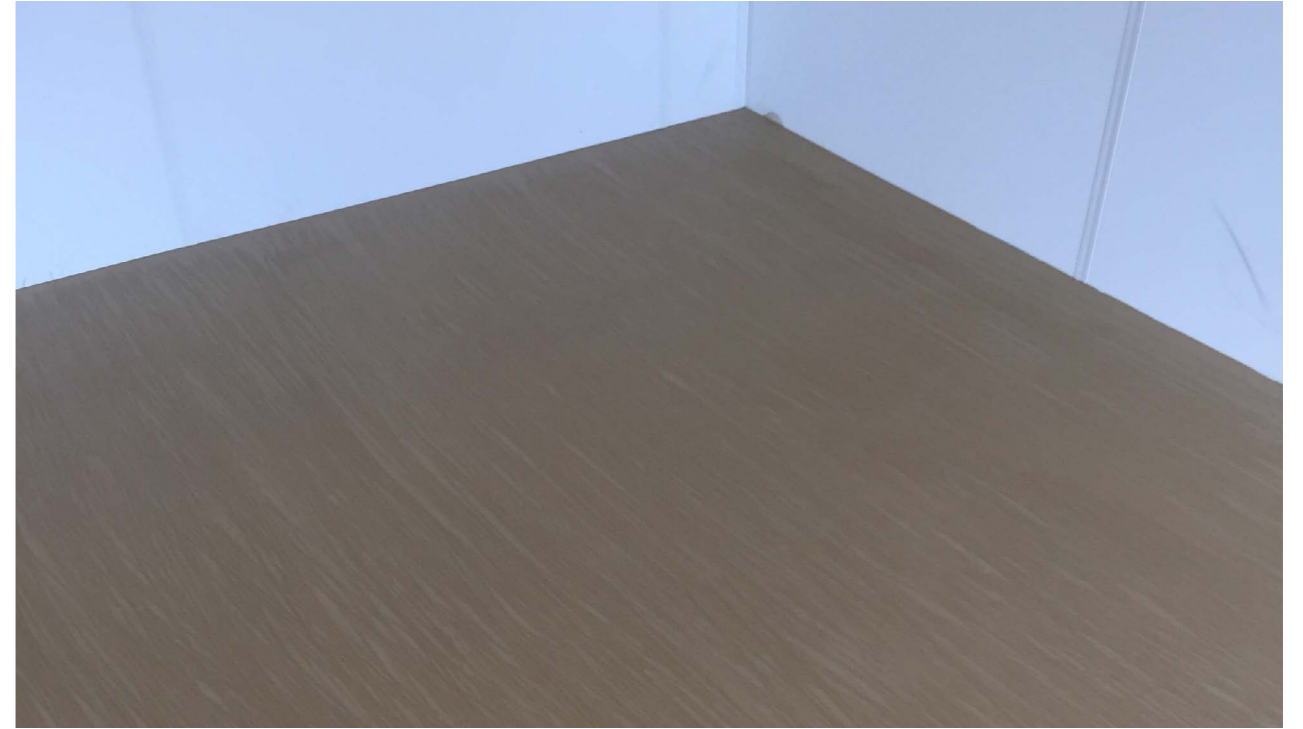
Με τη χρήση ειδικής σπάτουλας με ακίδες μπορεί να επιτευχθεί εφέ απομίμησης ξύλου.
