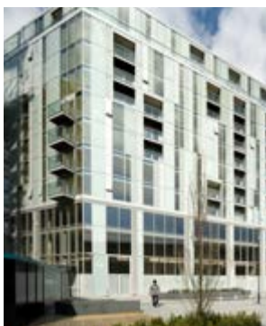
ΕΜΠΟΡΙΚΑ ΚΤΙΡΙΑ ΓΡΑΦΕΙΩΝ
