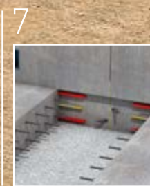
Αρμοί σύνδεσης διαφραγματικών τοίχων με πλάκες σκυροδέματος
