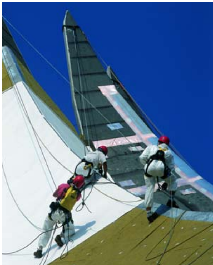
Τοποθέτηση μεμβράνης στο κτίριο Tempodrom, Γερμανία
