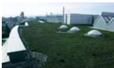
Κτίριο Επιχείρησης, Sursee, Ελβετία
