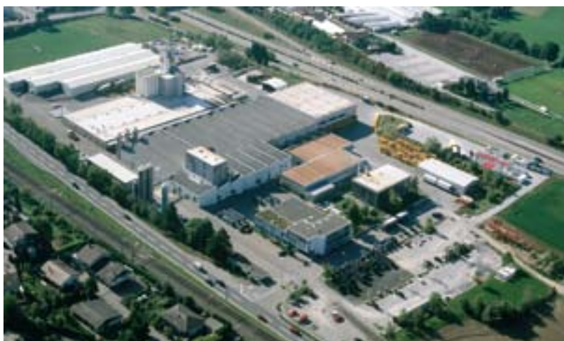
Εγκαταστάσεις παραγωγής, Dudingen, Ελβετία
