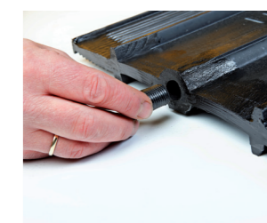
Τάπωμα του κεντρικού βολβού με αφρώδες υλικό κυψελοειδούς δομής και εισαγωγή μιας τάπας από ακατέργαστο καουτσούκ
