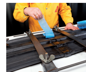
Ένωση της υδροφραγής, σύσφιξη με τους σφικτήρες σταθεροποίησης
