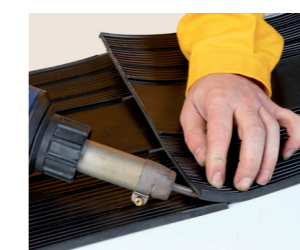
Συγκόλληση επικάλυψης με πιστόλι θερμού αέρα
