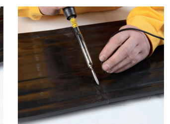
Ενίσχυση με κορδόνι συγκόλλησης χρησιμοποιώντας μύτη συγκόλλησης
