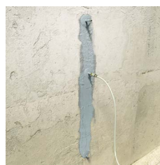
Επισκευή μη δομητικών ρωγμών
