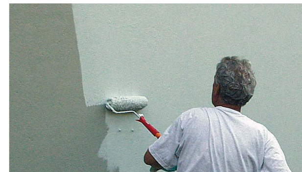
Οι προστατευτικές επιστρώσεις με βάση εποξειδική ρητίνη εφαρμόζονται σε ολόκληρη την επιφάνεια, ακολουθούμενες από επαναδιαμόρφωση της επιφάνειας σκυροδέματος με ανθεκτικό σε θειικά επισκευαστικό κονίαμα τροποποιημένο με πολυμερή.
