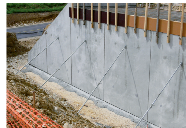
Προκατασκευασμένα στοιχεία σκυροδέματος
