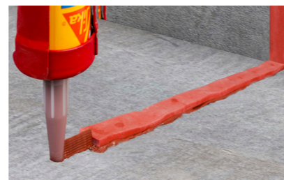
Πάνω εικόνα: Σφραγιστικό που χρησιμοποιείται αυτόνομα. Κάτω εικόνα: Σφραγιστικό που χρησιμοποιείται ως συγκολλητικό για το προφίλ.
