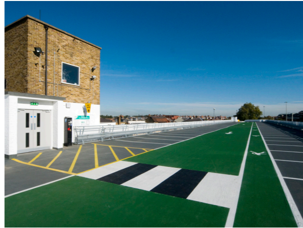
Χώροι στάθμευσης αυτοκινήτων
