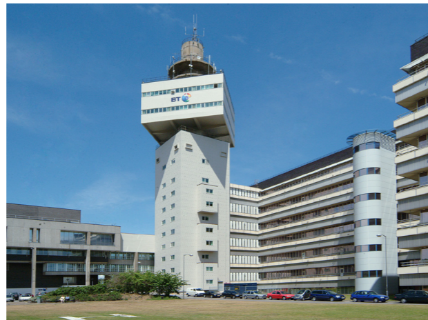
Κατασκευές οπλισμένου σκυροδέματος
