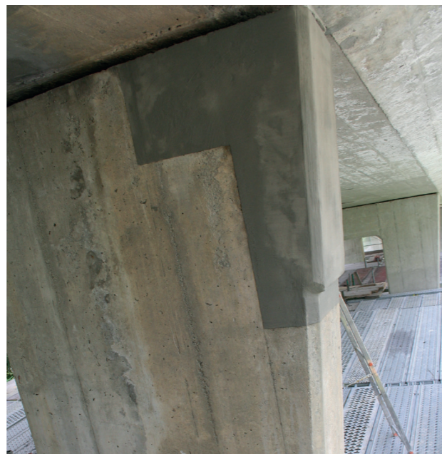
Αποπεράτωση εργασιών επισκευής
