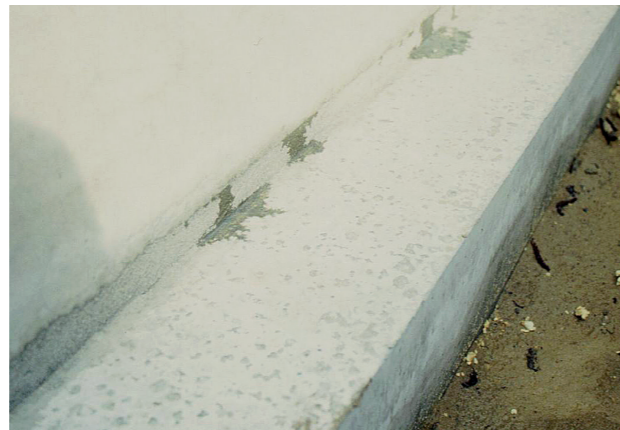
Απλή διαδικασία ενεμάτωσης στο έργο
