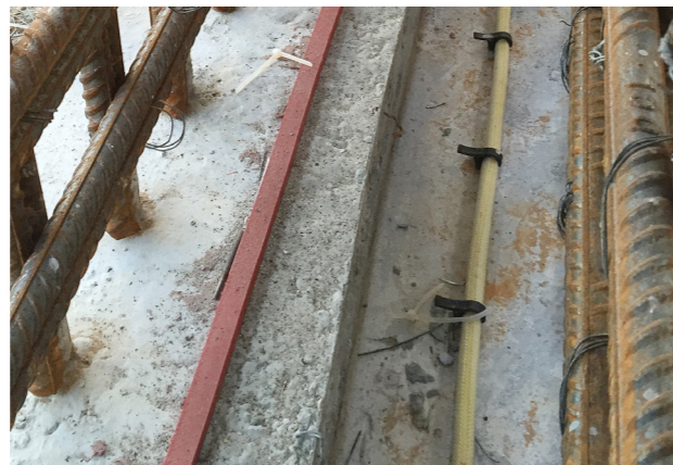
Συνδυασμός του συστήματος SikaFuko® με SikaSwell® A Profile
