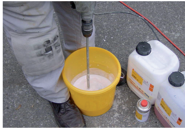
Ανάμειξη της ακρυλικής βάσεως ρητίνης ενεμάτωσης
