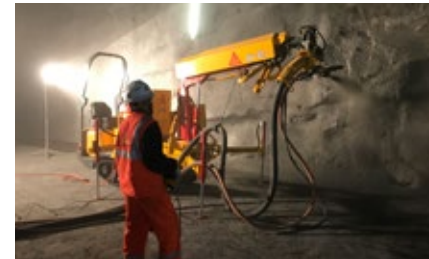
Fig. 6.5: Aliva®-503.3 Mini shotcrete spraying system
